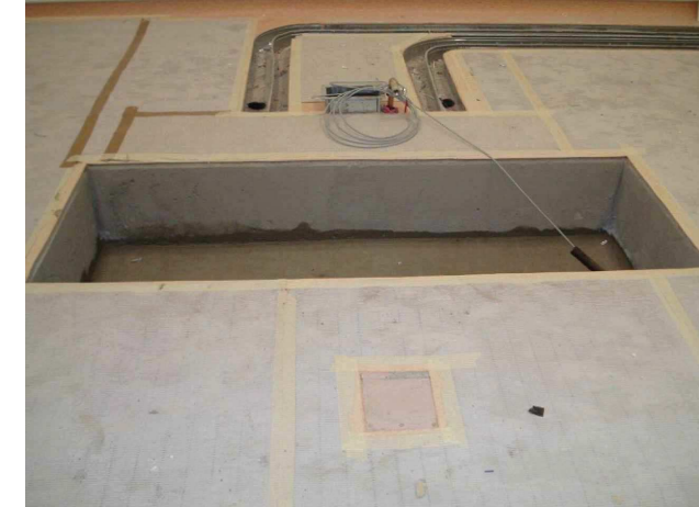
C5 DALLE DE FONDATION APRES COULAGE DU BETON (OPTION 1) PAS A L'ECHELLE
