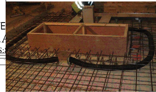
D5 DALLE DE FONDATION AVANT COULAGE DU BETON (OPTION 1) PAS A L'ECHELLE
