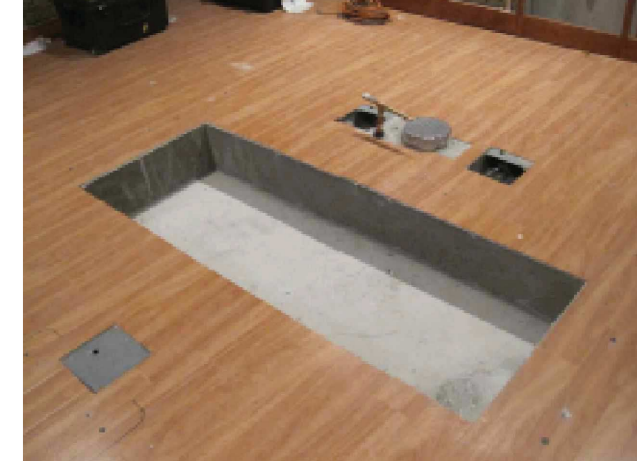
A5 DALLE DE FONDATION APRES COULAGE DU BETON (OPTION 2) PAS A L'ECHELLE
