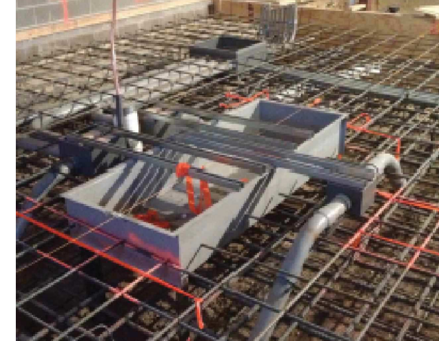
B5 DALLE DE FONDATION AVANT COULAGE DU BETON (OPTION 2) PAS A L'ECHELLE
